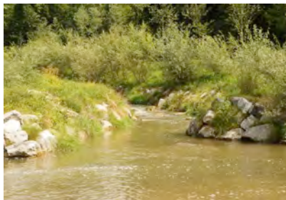
Abb. 5.5.1: Einstieg in den Beckenpass/Umgehungsgerinne neben dem Wehr.
