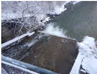
Abb. 5.3.2: Wehrüberlauf an der abge-senkten linken Wehrschütze. Dahinter der Einstieg zum Beckenpass.
