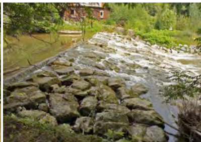
Abb. 5.5.2: Seitenansicht der Blockrampe. Im Hintergrund rechts der Einstieg zum Umgehungsgerinne.
