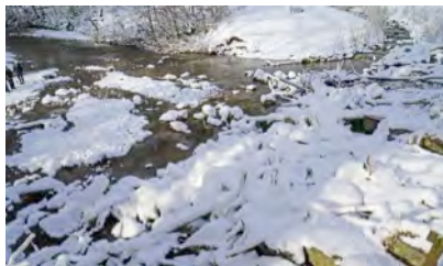
Abb. 5.6.1: Einstieg in den Beckenpass rechts unterhalb des Wehrs (Hintergrund oben rechts).
