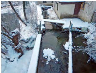
Abb. 5.3.5: Ausleitungskanal zum ehe-maligen Triebwasserweg. Links der Schieber für den Entlastungsweg.
