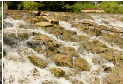
Abb. 5.5.3: Flache und turbulente Wasserführung in der Blockrampe.
