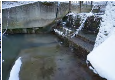
Abb. 5.4.2: marode Betonplatten und -reste im flachgründigen Unterwasser.
