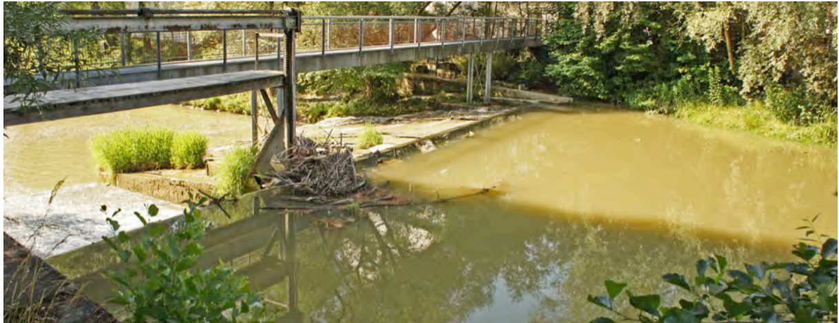
Abb. 5.3.1: Anordnung der Wehranlage an der Rundelmühle. Links das ehemalige Wehrschütze, rechts daneben die Betonrampe mit leicht erhöhter Wehroberkante. Ganz rechts der Ausleitungskanal. Situation 2013.
