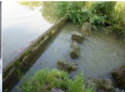
Abb. 5.3.3: Oberer Ausstieg des Beckenpasses mit Tauchwand.
