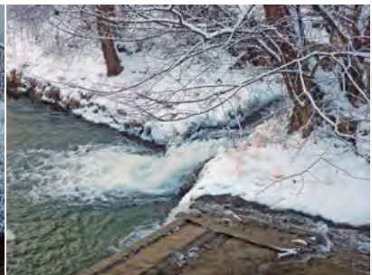
Abb. 5.3.6: Entlastungsweg des Ausleitungskanals.
